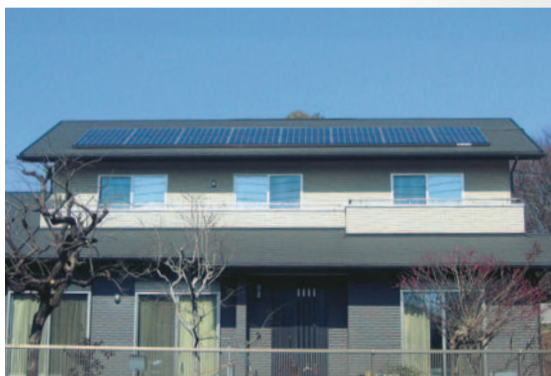
▲太陽光発電設置住宅
