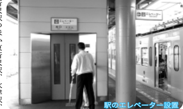
駅のエレベーター設置
