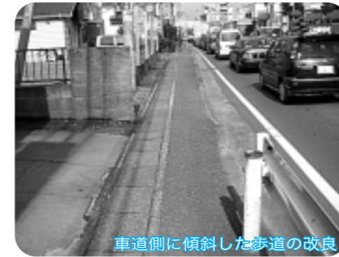
車道側に傾斜した歩道の改良
