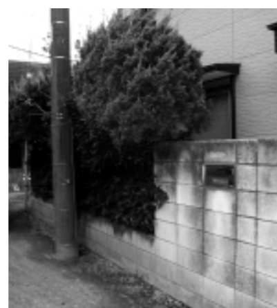
▲道路にはみ出した樹木
