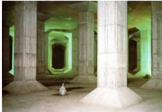
緑町中央公園調整池（地下式）
