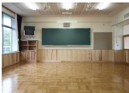
中学校校舎内部改修（木質化）事業
