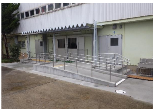
屋内運動場のスロープの整備
