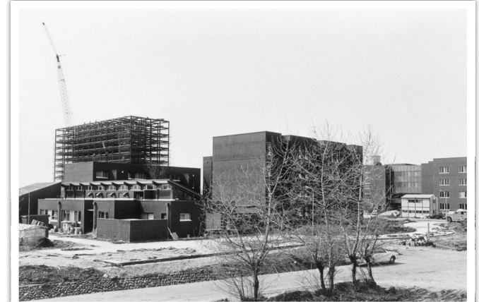
▲ 建設中の防衛医科大学校病院 (1972・昭和47年)
