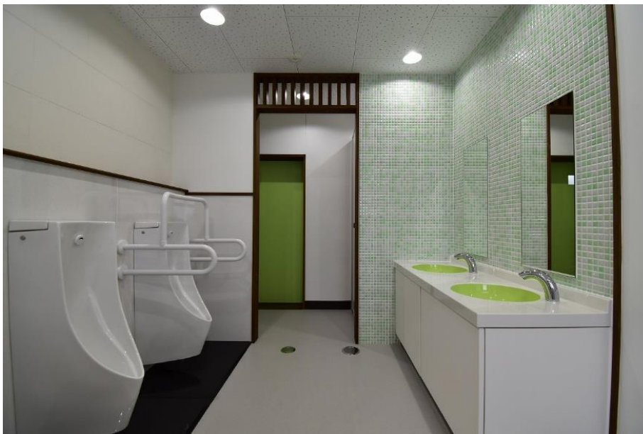
学校トイレ改修(林小学校)
