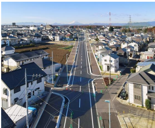
▲北野下富線（3工区開通）
