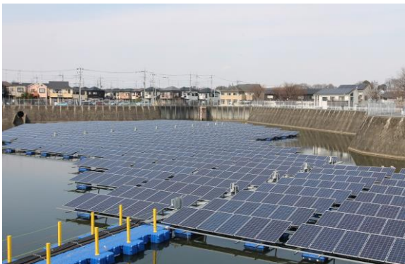
フロート式太陽光発電(設置:松が丘調整池)
