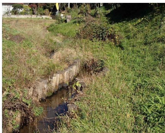
水辺のサポーターによる清掃活動をしている地区 (山口菩提樹現地水路)
