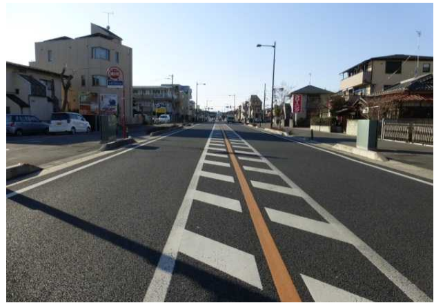
電線地中化（所沢村山線）
