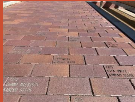
舗装のレンガには、パイオニア・コートハウス・スクエアと同様、寄付者の刻印がある
