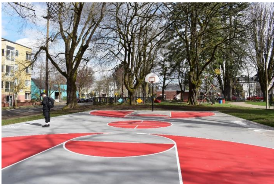
▲改修されたバスケットコートのある公園 (ドーソンパーク)
