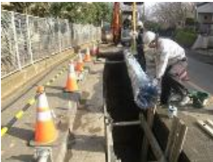
■ 配水管の布設替工事
