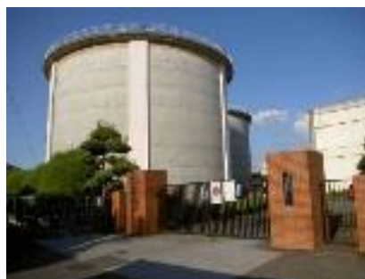
■ 第一浄水場配水池
