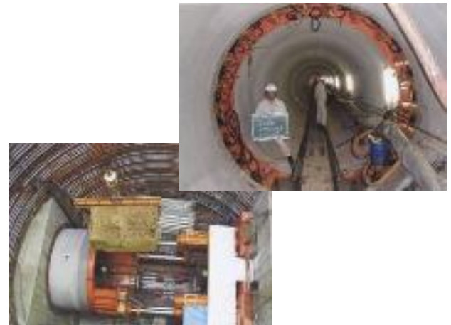
■小手指貯留施設築造工事(合流式下水道緊急改善事業)
