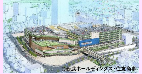
↑エミテラス所沢 令和6年9月24日グランドオープン。
