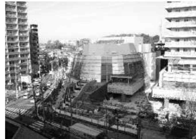
完成間近の(仮称)所沢元町北地区公益施設
