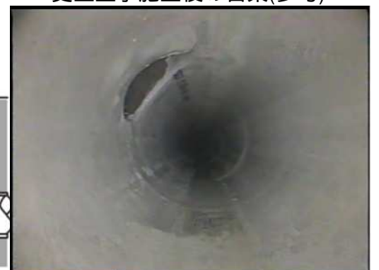
更生工事施工後の管渠(参考)
