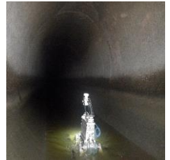
▲直径4mの管のカメラ調査
