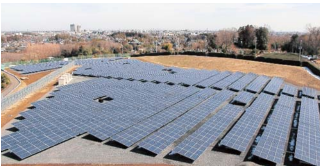
電源調達先の例(所沢メガソーラー所沢)
