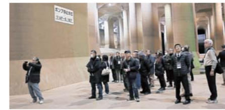
庄和排水機場にある調圧水槽の様子
