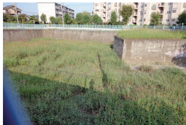
調節池・調整池
