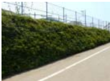
図 1-2-19 緑化擁壁の例
