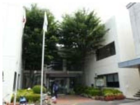
図 1-2-7 エントランスの修景植栽の例 (教育センター)
