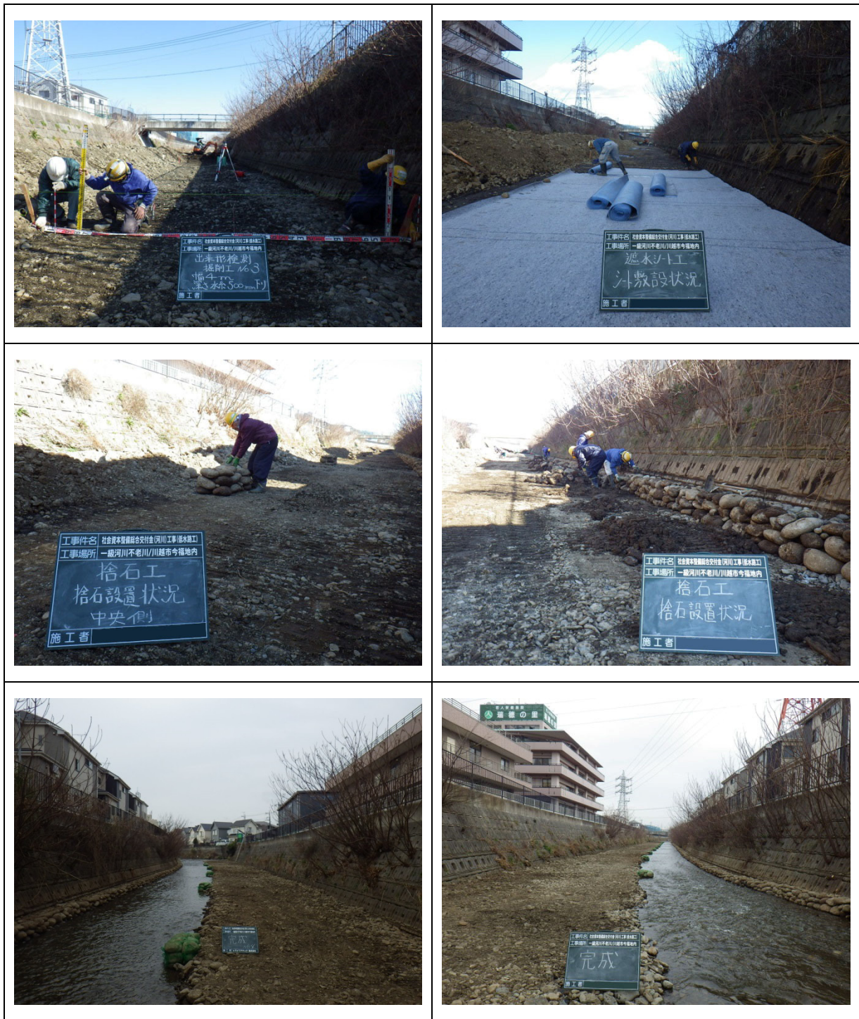
図 5.3 工事中および竣工時の状況
