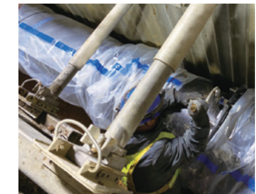
水道管更新工事
