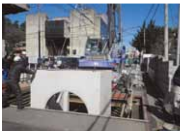
マンホール耐震工事の様子
