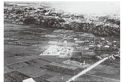
建設当時の第一浄水場
