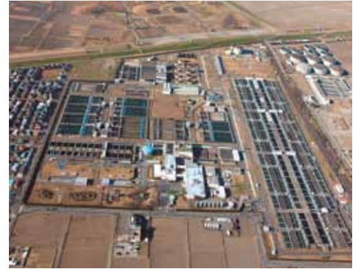
埼玉県大久保浄水場 (写真：埼玉県企業局提供)
