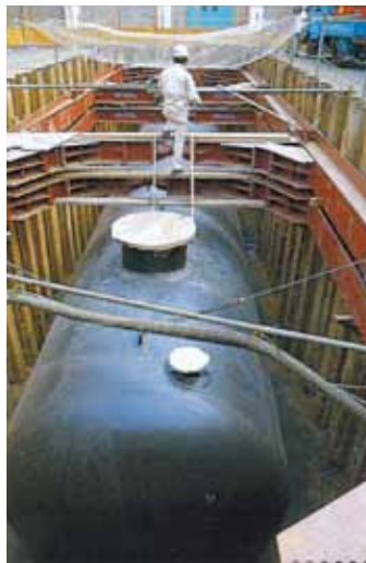
耐震性貯水槽の工事の様子
