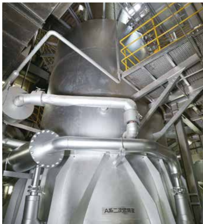
焼却炉 焼却炉は全連続燃焼式流動床炉を採用しています。147t/日(73.5t×2炉)の焼却能力があり、焼却炉出口付近で850℃以上となるため、ごみを完全燃焼させることができます。焼却炉内には窒素酸化物を除去するための薬剤を吹き込んでいます。
