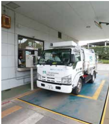
ごみ計量機 収集されたごみを入場時に自動的に計量・記録し、集中管理します。
