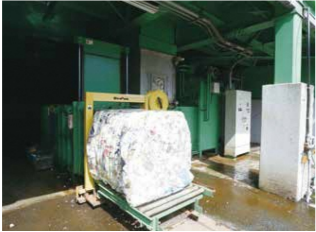
圧縮梱包機 回収されたプラスチックを圧縮し、梱包します。
