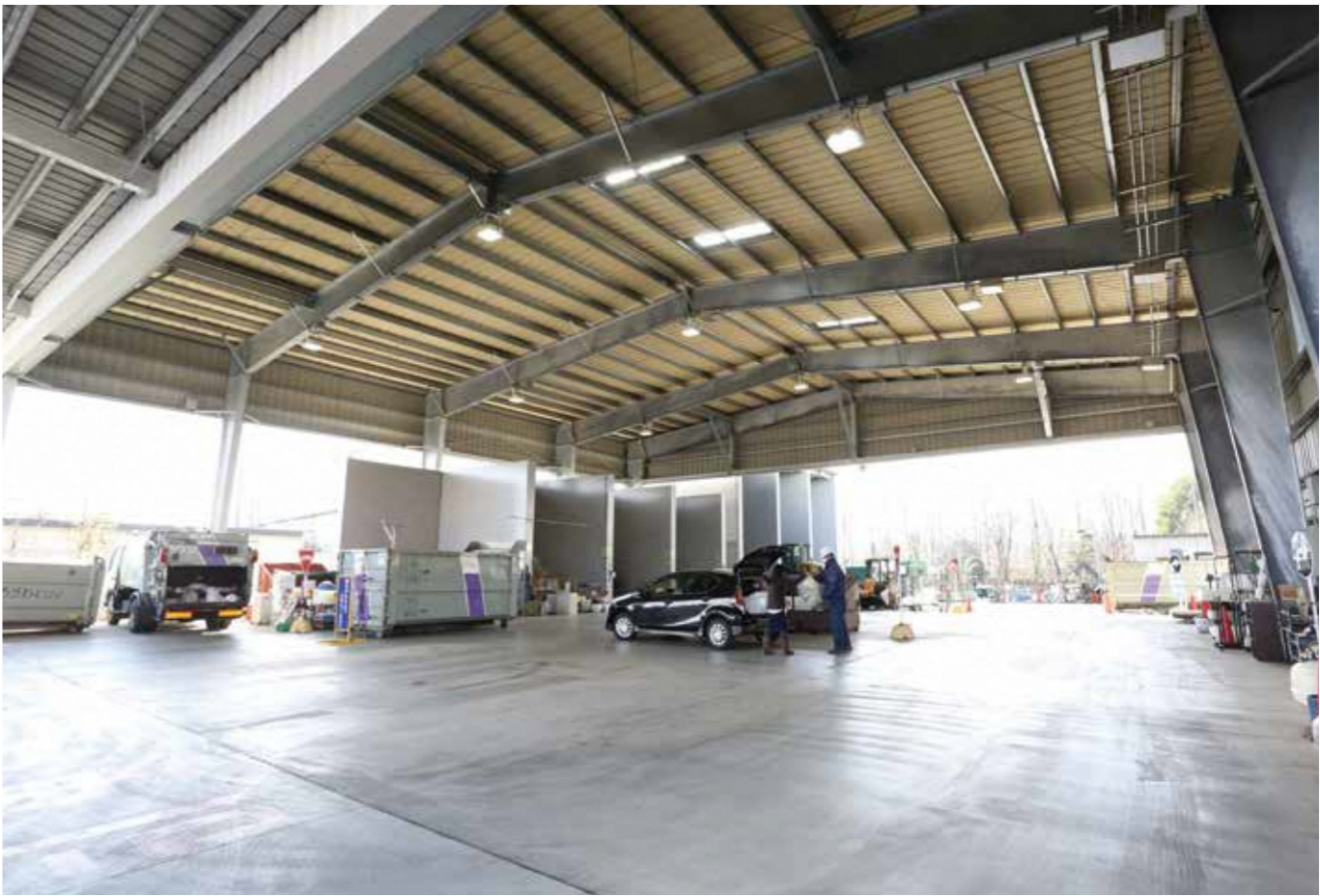
受入ステージ棟(内部) 持込まれた家庭ごみの分別、軽微な解体、保管を行う場所です。
