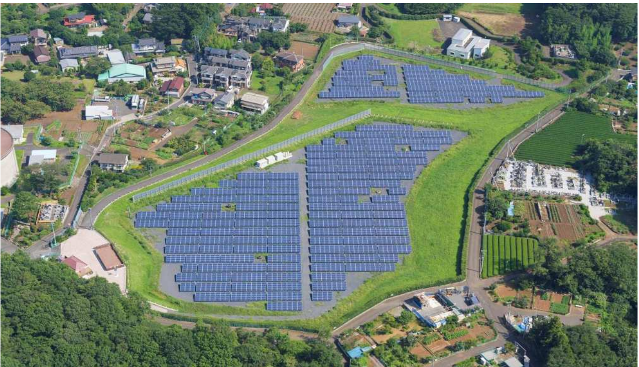
北野一般廃棄物最終処分場の上部を利用し、メガソーラーを設置（平成 26 年 3 月より稼働）
