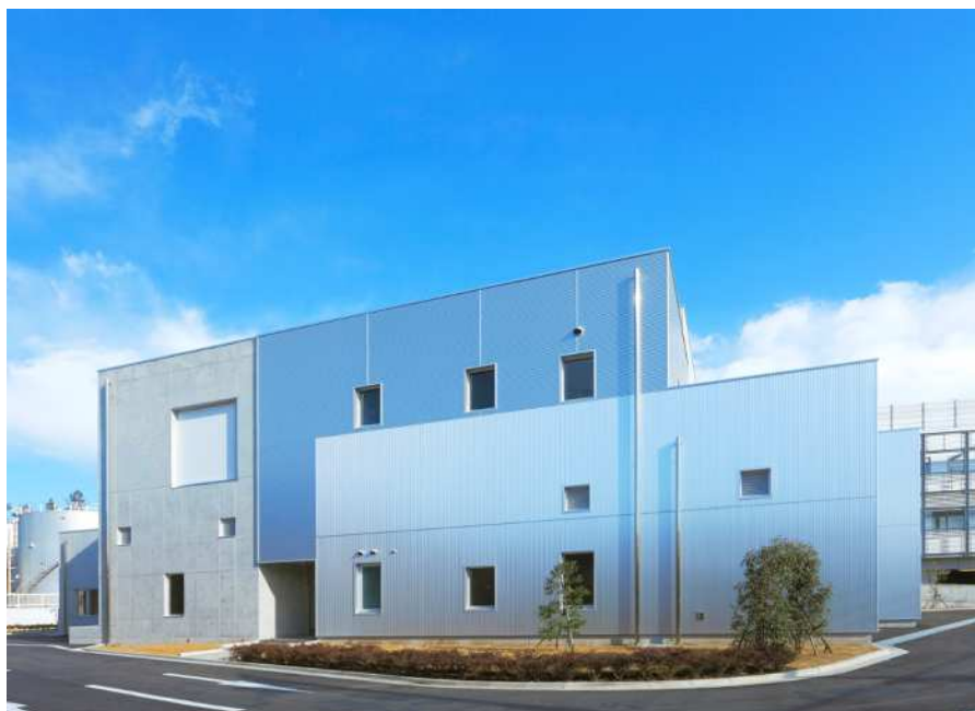
所沢市衛生センター
