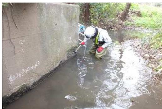
図8 橋梁の定期点検の実施状況
