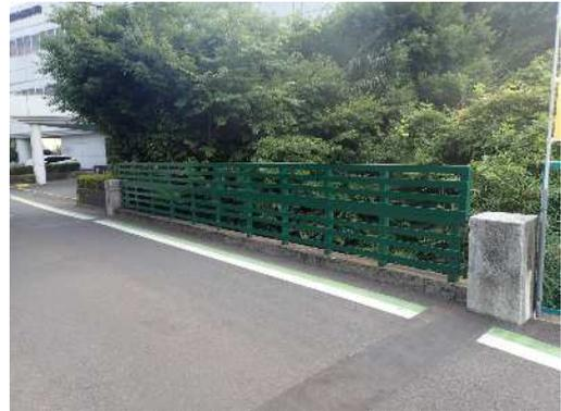
図 1 2 H31 橋面補修工、防護柵塗替え工
